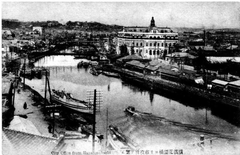
図3 派大岡川と市役所付近
