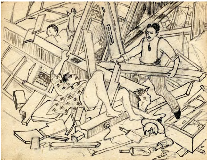
救助活動を行う八木熊次郎 八木彩霞画『大正十二年九月 関東地方大震災画録』 倒潰した理髪店では、数人が建物の下敷きとなっていた。八木熊次郎は周囲に対し、救援活動の協力を求めたが、被災者たちは自らの生命を守ることので精一杯だった。そのため熊次郎は1人で救助活動を行った。
